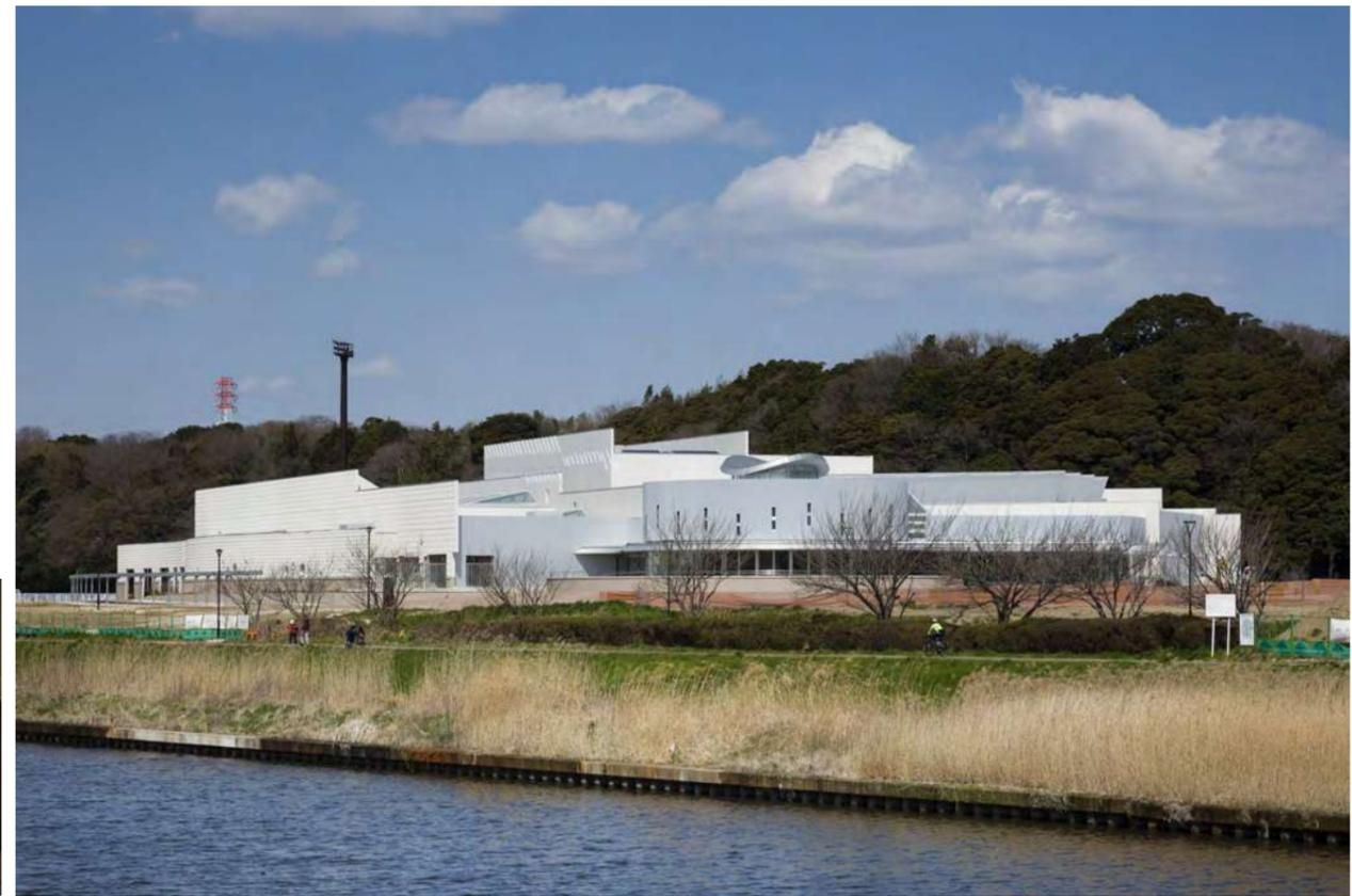
外壁：コンクリート特殊型 枠打ち放し、超汚染型弾性 フッ素樹脂エナメル塗装。それ以外では、妻壁：アルミスパンドレル アルマイト仕上、腰壁：せっき質タイル張 (ランダム張)
