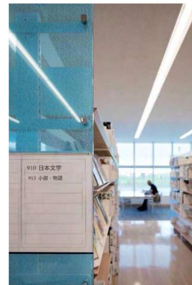
側板のデザイン：川の流りに沿う列ごとに、レースカーテンを挟み込んだアクリル2枚の色を変え場を個性化させる
