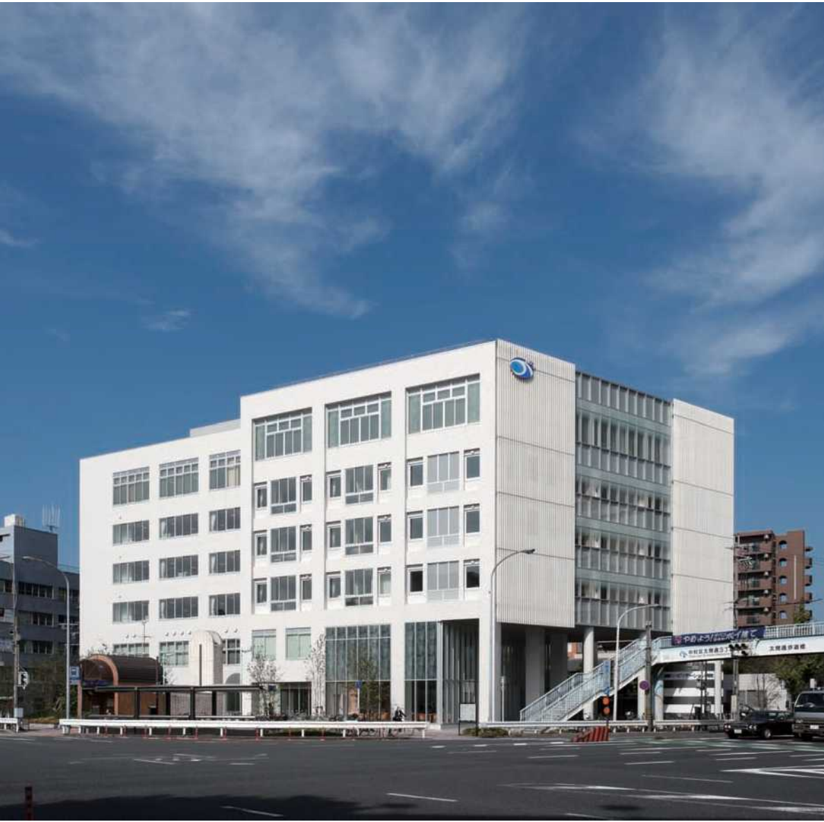
南東側からの外観，交差点に面する
