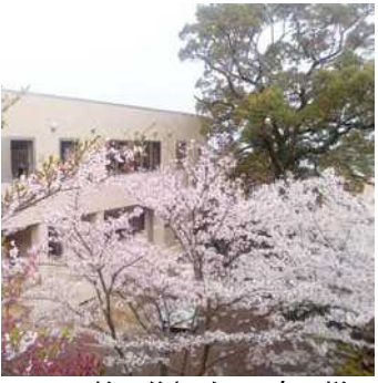
竣工後初めての春の様子
