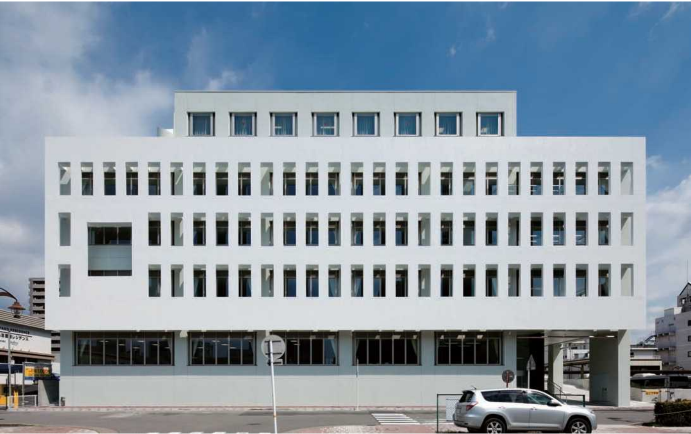
南側外観 外壁から1m離れた白壁が、建物に軽やかなリズムを与える
